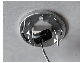
引掛けシーリング
